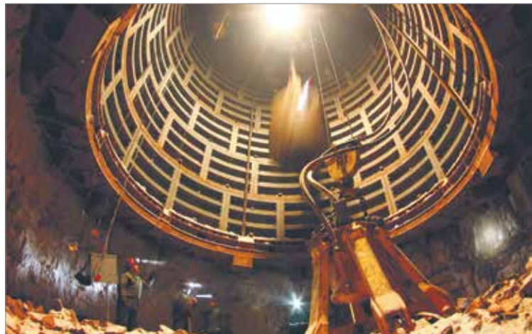
Szyb SW-4 w trakcie głębenia
